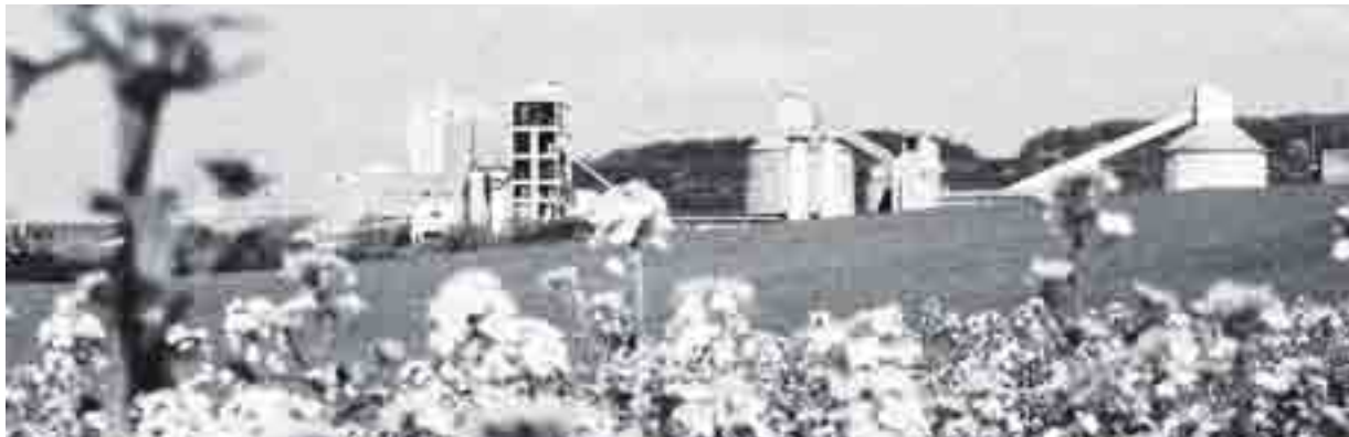
Stabilimento di Göllheim in Germania
