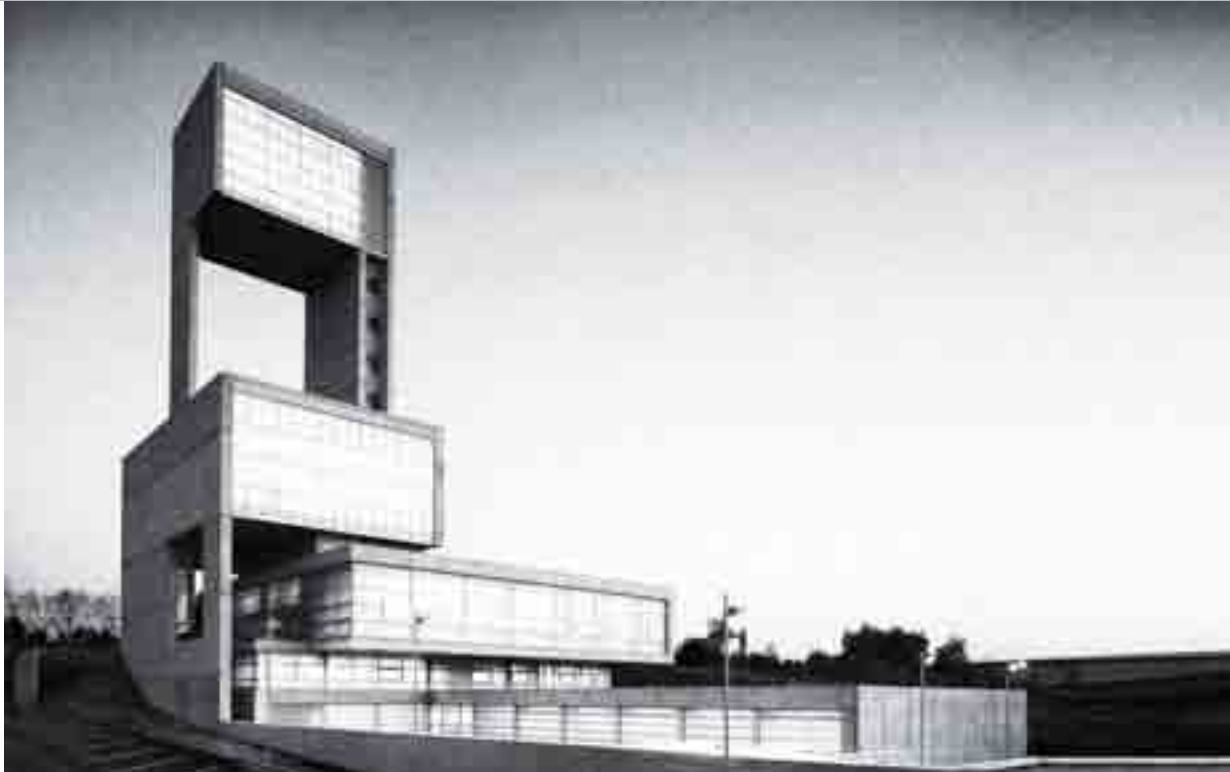
Cisterna di Leudelange in Lussemburgo realizzata dallo studio di architettura Schemel & Wirtz
