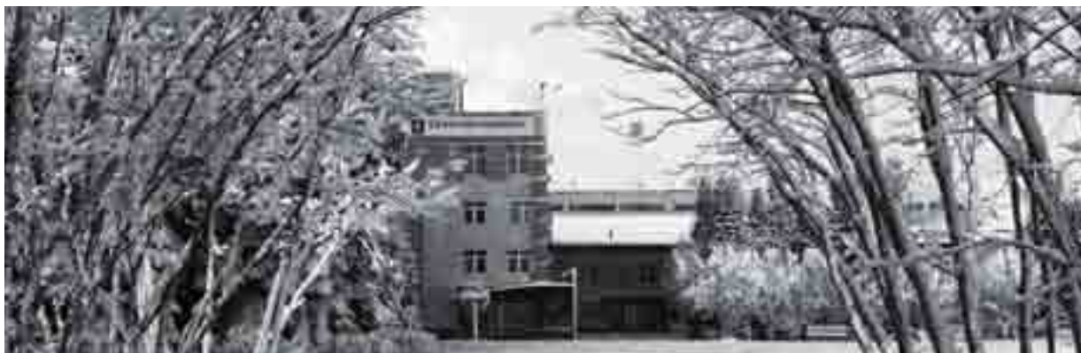
Stabilimento di Suchoi Log in Russia
