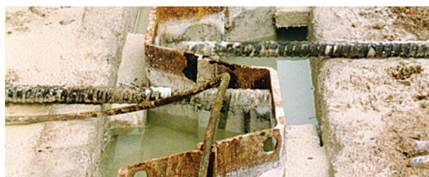
Passerelle introduite dans le diaphragme avec Solidur® encore à l'état liquide
