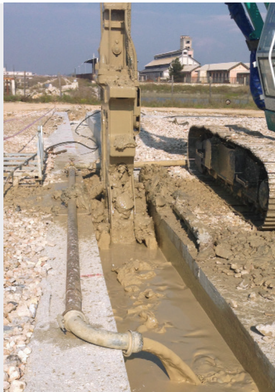
Diaphragme de 60 cm. On peut réaliser des diaphragmes jusqu'à 1,20 m de largeur
