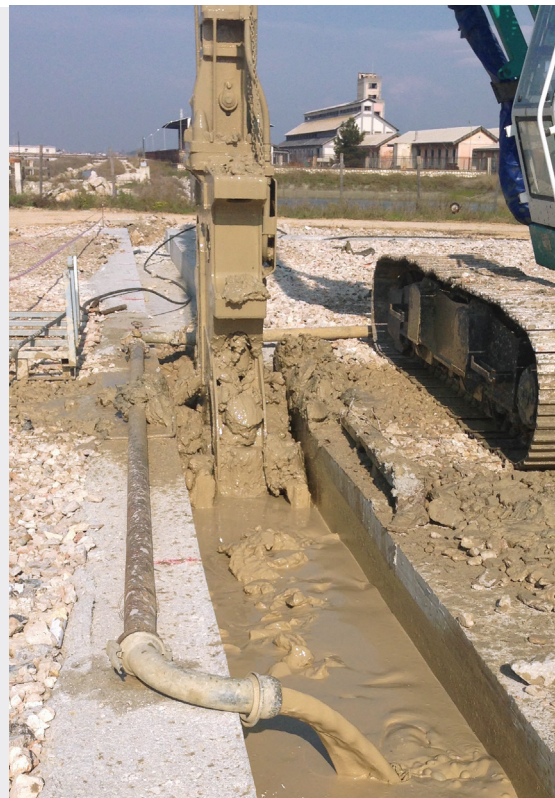
Diaframma di 60cm. Sono realizzabili diaframmi fino a una larghezza di 1,20 m.
