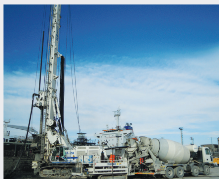
Costruzione di una barriera impermeabile tramite pali CSP (cased secant piles). Posa in opera di calcestruzzo plastico a base di Solidur® Erdbeton
